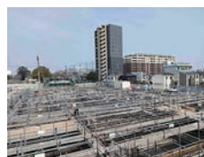
体育館工事現場
