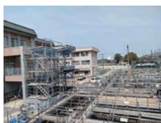
新校舎と体育館工事現場
