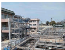
新校舎と体育館工事現場
