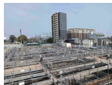
体育館工事現場
